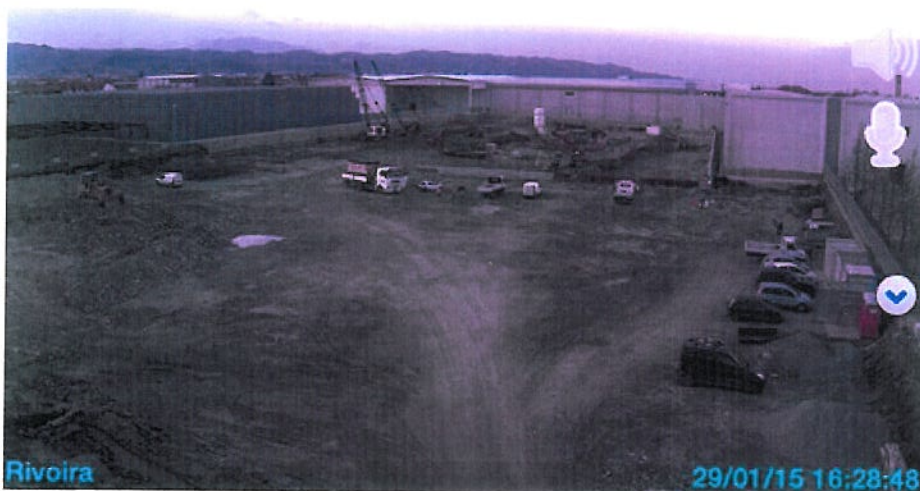
Panoramica dei lavori in corso.
